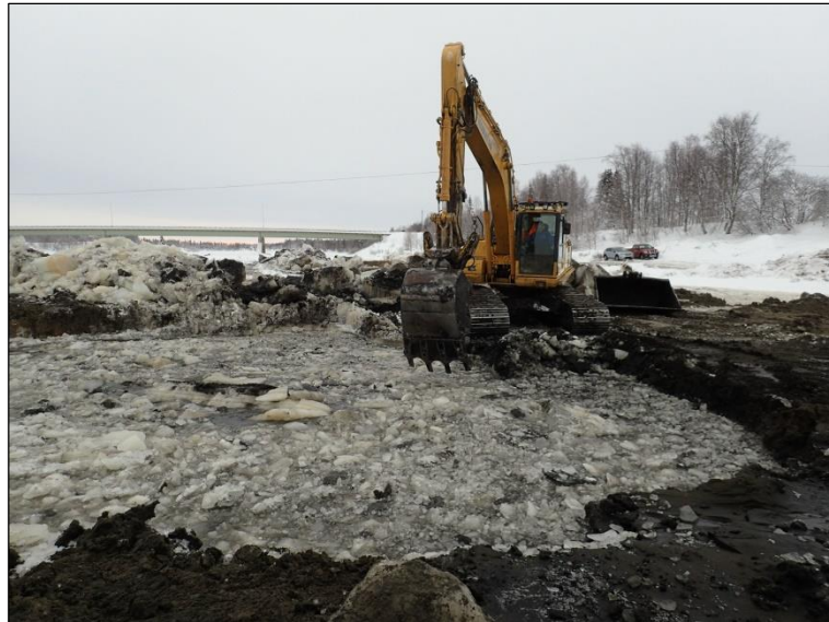
Kaivinkone hajotti jään piikkikällä kauhalla. Etelään.
