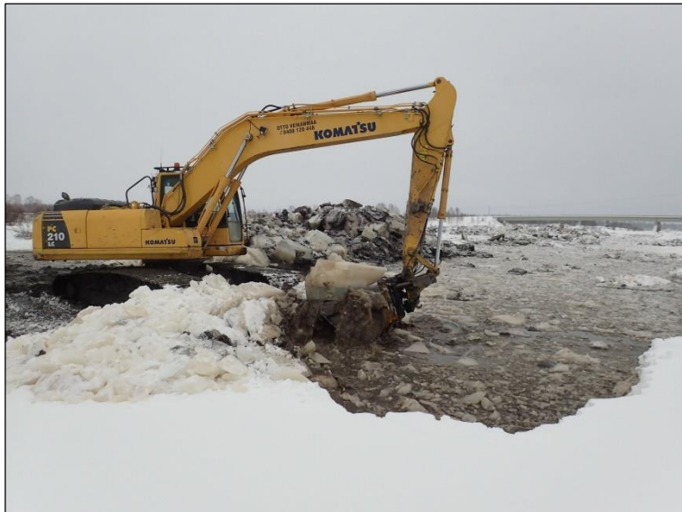
Jään rikkomista valvotun alueen luoteisosassa. Jään paksuus oli noin 85 cm. Itäkaakkoon.
